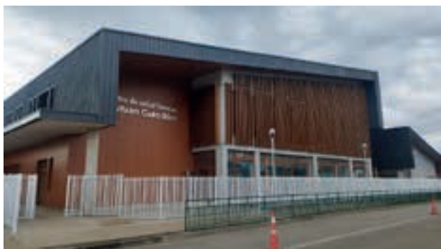
97% de avance en la construcción del nuevo Cesfam
