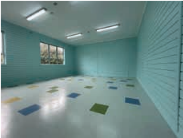
Trabajos de mejoramiento en Escuela Nueva Aurora
