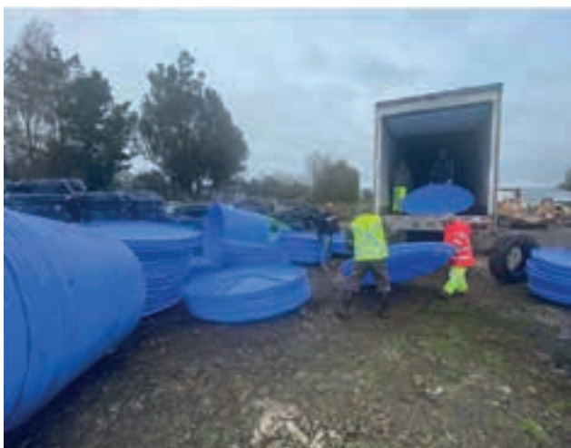
183 familias recibieron estanques para almacenar agua potable
